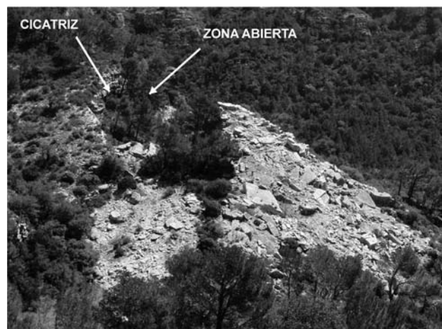
Figura 13.- Fotografía del deslizamiento meridional, tomada desde la vertiente occidental del barranco del Manou, hacia el este. Se observa la cicatriz, la zona abierta y la acumulación de bloques. El bloque traslacional queda tapado por los pinos que crecen en la zona abierta.
