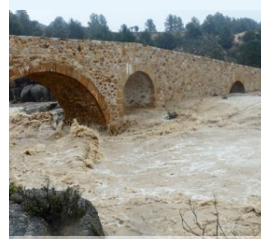
Puente de Cananillas durante la avenida de marzo de 2015.
